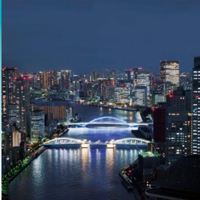
▲隅田川橋梁群(築地大橋、勝鬨橋)
